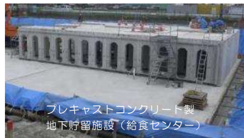
<雨水貯留施設設置事例>
