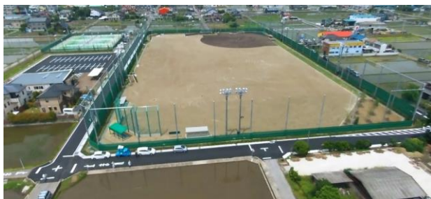
総合運動広場建設 (H25～27) 約 11.0 億円 (うち10.2億円)
