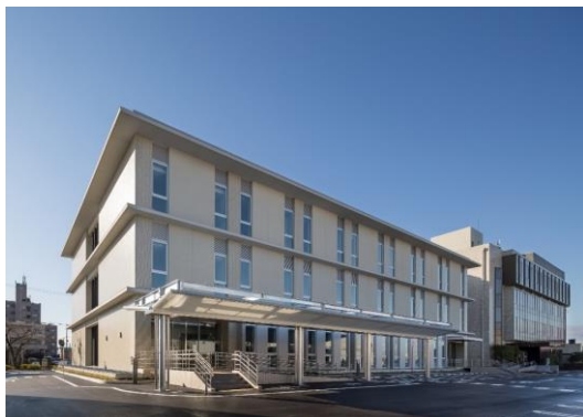
西庁舎分館建設・ 西庁舎耐震工事 (H25～27) 約 20.4 億円 (うち16.7億円)
