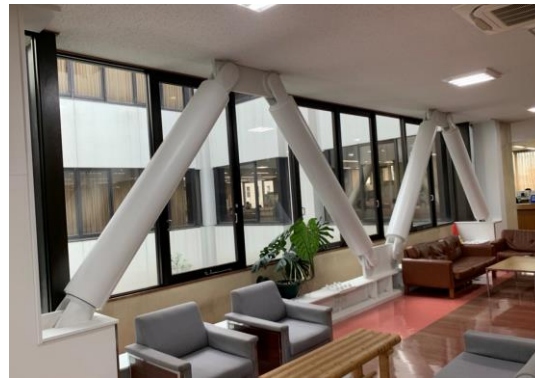
東庁舎耐震工事 (H28～29) 約 6.4 億円 (うち5.7億円)
