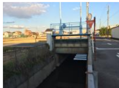
農業水利施設
