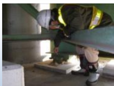
道路橋梁の点検
