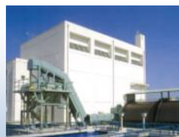
電車川ポンプ場の長寿命化対策
