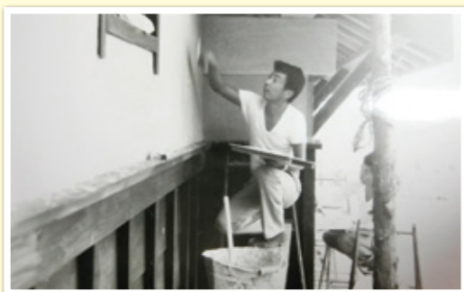
漆喰塗りの様子(犬山城修繕当時)
