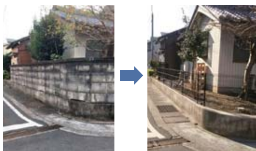
改修前 改修後 (改修実例)
