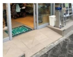
【 スロープの設置 】
