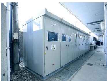
【キュービクルの更新(総合体育館)】
