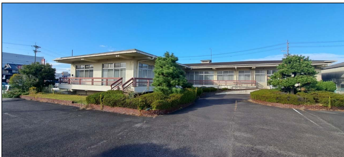
建物（南側から撮影）
