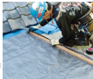
シートの端を野地板で固定
