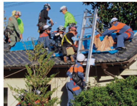
実際に屋根で、土のう袋取り付け作業
