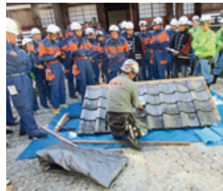
ミニチュアの屋根の部分補修の説明 ブルーシートを張るまでもない破損は、部分的にシートを当てて応急処置をする。
