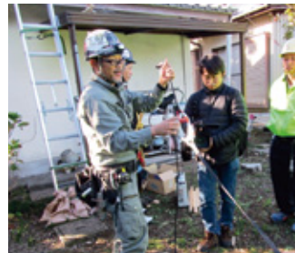
屋根に上る前の安全確認
