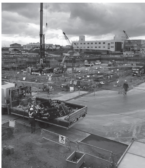
清掃工場建設現場
