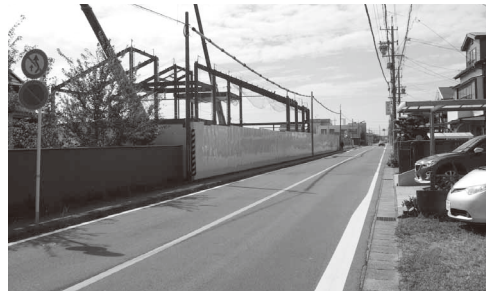
建設中児童センター北側道路
