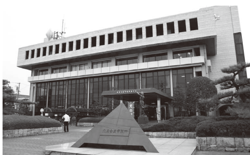
市役所東庁舎
