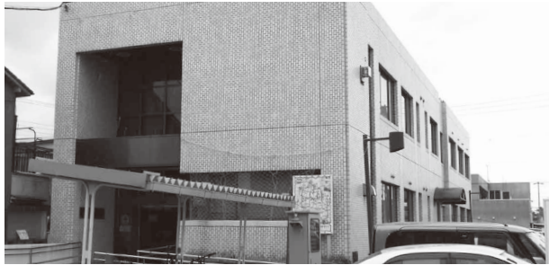
青少年センターの入る東庁舎分館
