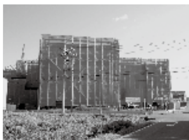
建設が進む第5特養（平安の里）
