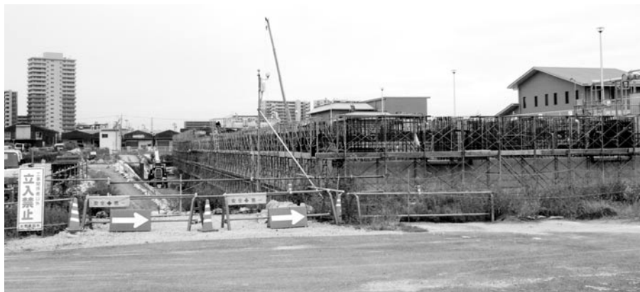
工事が進む新川東部浄化センター
