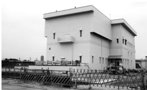
工事が進む久地野ポンプ場
