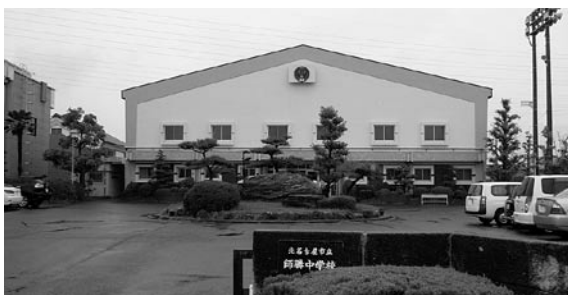
補強工事を終えた師勝中学校体育館
