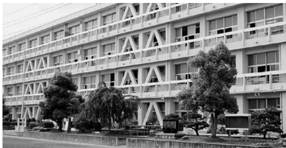
耐震補強工事を終えた五条小学校
