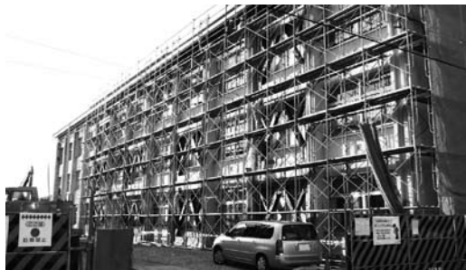
工事が進む西春中学校
