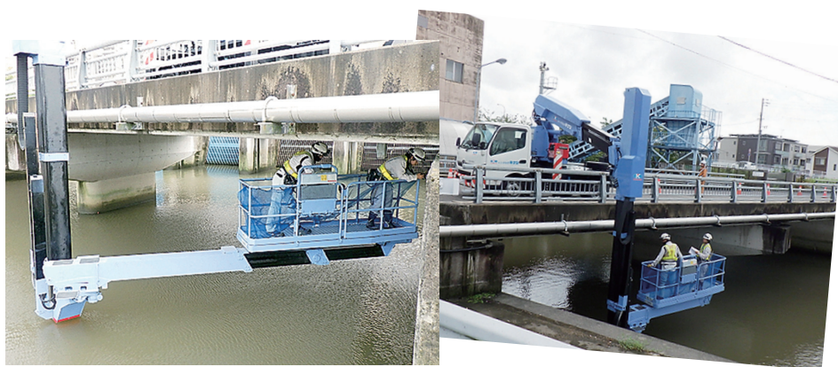
新鴨田橋の橋梁点検
