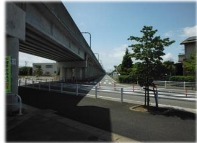
整備事例：名鉄津島線藤浪駅付近
