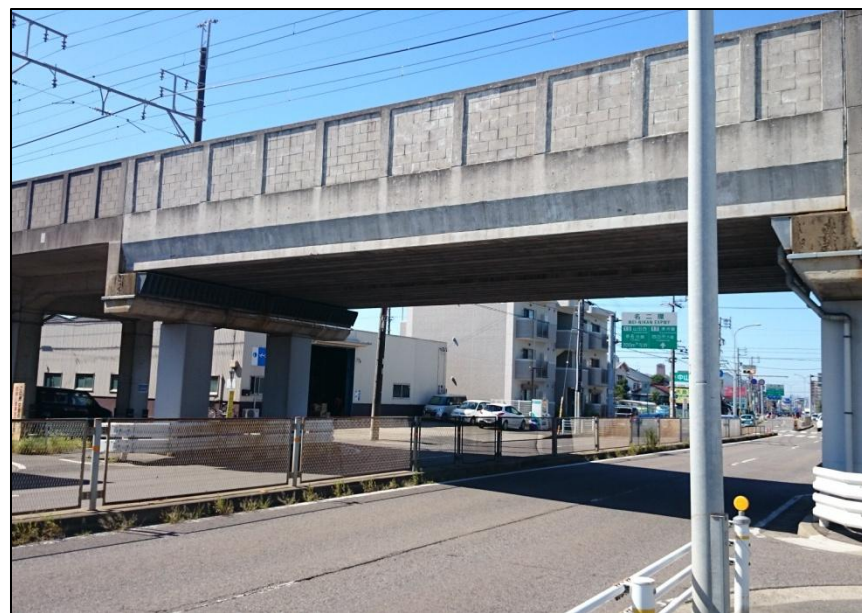
名鉄犬山線西春駅南側の鉄道高架の事例
