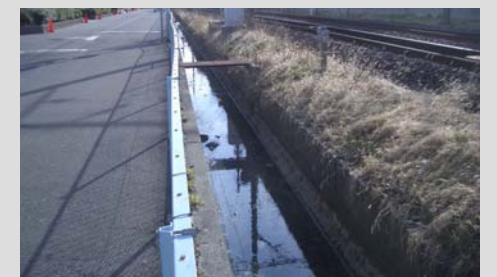
写真① 鹿田第1公園付近の用水路
