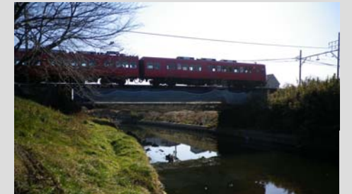
写真① 名鉄犬山線の橋梁 (五条川)
