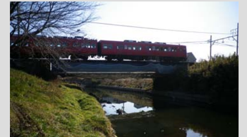
写真① 名鉄犬山線の橋梁 (五条川)
