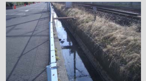
写真① 鹿田第1公園付近の用水路
