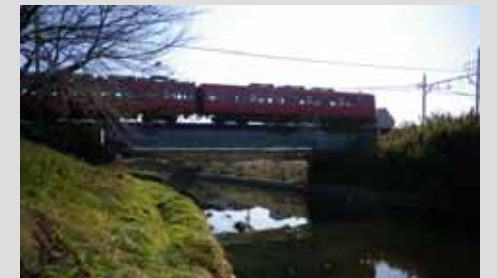
写真① 名鉄犬山線の橋梁 (五条川)
