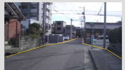
写真⑤ 旧町境付近の道路幅員の不連続
