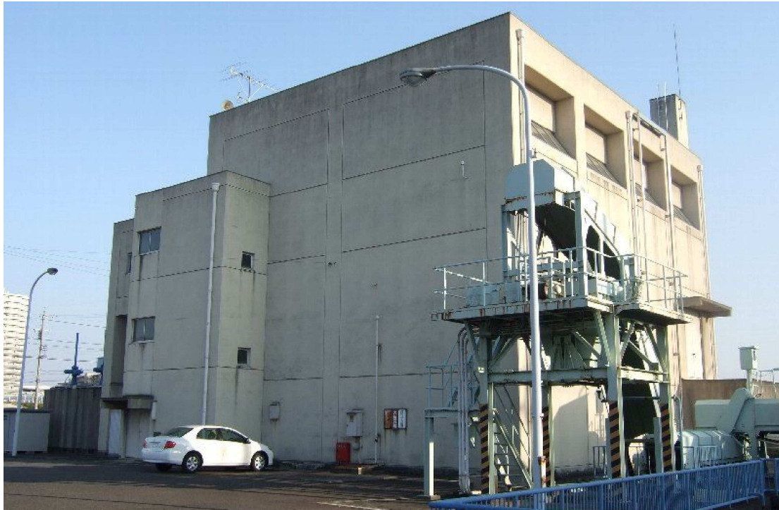
図 4-9. 電車川ポンプ場
