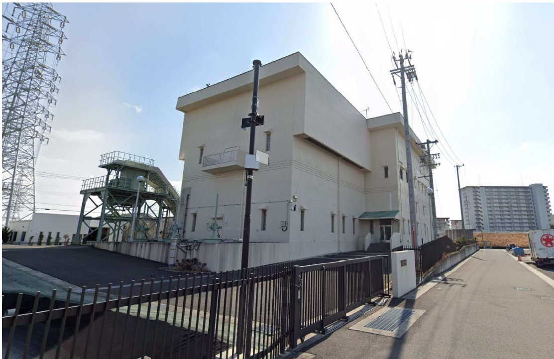
図 4-10. 久地野ポンプ場
