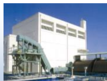
電車川ポンプ場の長寿命化対策
