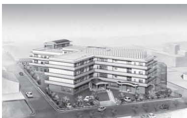
鉄筋コンクリート造4階建 特別養護老人ホーム(定員96人) ショートステイ(定員30人) 老人デイサービスセンター(定員30人)
